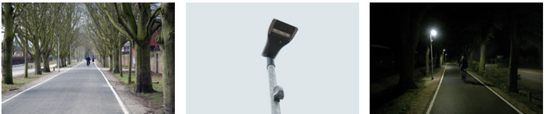
Abb. 4.4: Radschnellweg Osnabrück–Belm, die Steuerung der Dimmung erfolgt über Bewegungsmelder (Fotos: Simon Dierken, Stadt Osnabrück)
